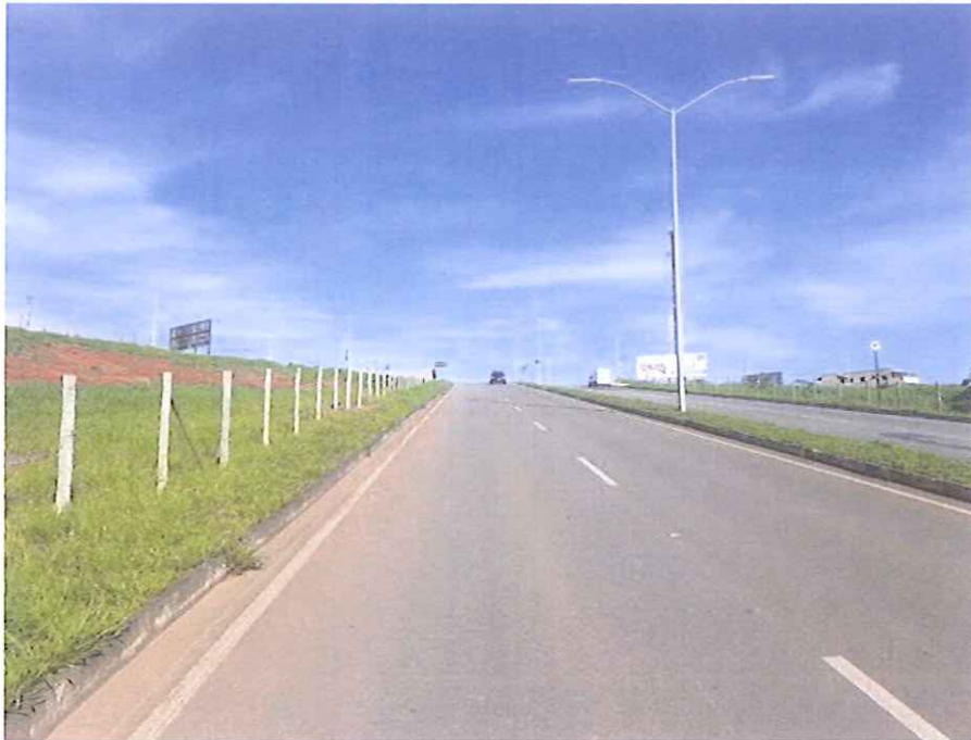
Local Fiscalizado Bairro - Centro
