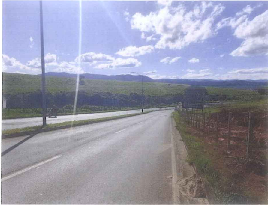
Local Fiscalizado Bairro - Centro
